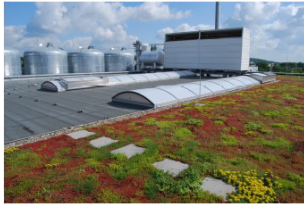
Bild 2 Extensive Dachbegrünung auf einem Industrieleichtdach
