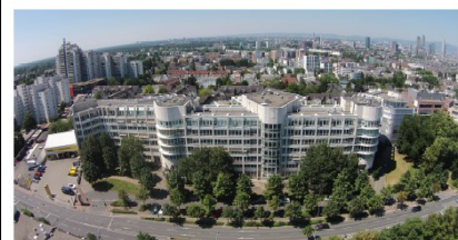
Bild 2 Umbau statt Abriss: aus dem Bürokomplex Sky wird View 180
