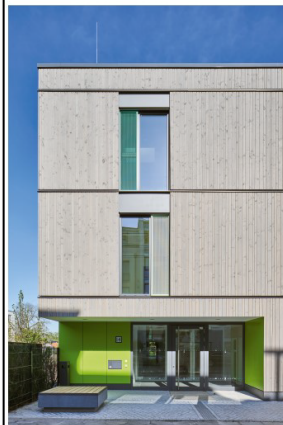
Bild 1 MOKIB Berlin: sieben von neun Kitabauteilen sind in modularer Holzbaweise als zweigeschossiger Typ 60 plus oder dreigeschossiger Typ 150 minus bereits fertiggestellt. Leistungen Schüler:Plan: u. a. Projektsteuerung und -controlling
