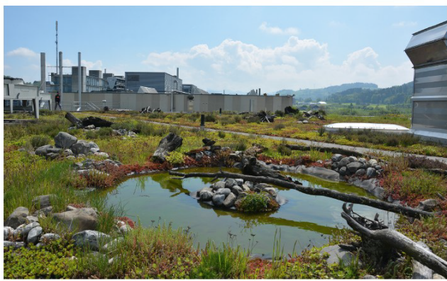
Bild 1 Für Dachbegrünungen gibt es viele Möglichkeiten: von der Wildblumenwiese über den Garten bis zum Kleinkraftwerk oder Dachbiotop – wie etwa hier auf einem Supermarkt
