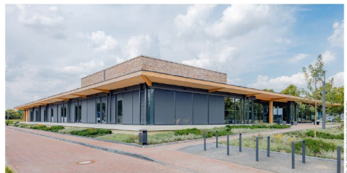
Cradle-to-Cradle-Projekt Kreisarchiv Viersen - Klinker aus Fabrikabbruch, Umräumungsgebäude in Holzbaueise
