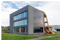
Das Gebäude produziert mehr Strom, als es selbst verbraucht, drei der vier Seiten sind mit Solarzellen ausgestattet
