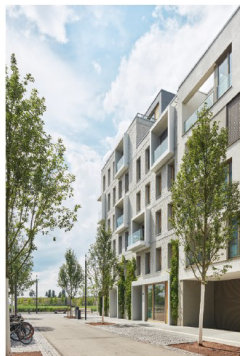
Besonderes Kennzeichen der Grünen Ecke ist ihre Fassade aus Liapor-Leichtbeton, an der sich wilder Wein emporrankt
